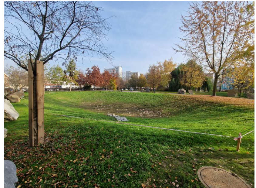
Vsakovací nádrže u hlavní budovy PŘF 17. listopadu
