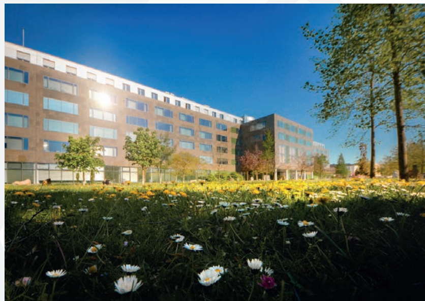
Obrázek 3: Budova Přírodovědecké fakulty UP na Envelopě
