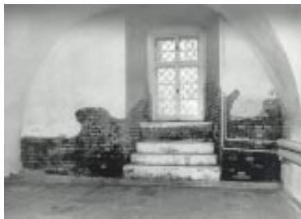
Stav interiéru před rekonstrukcí
